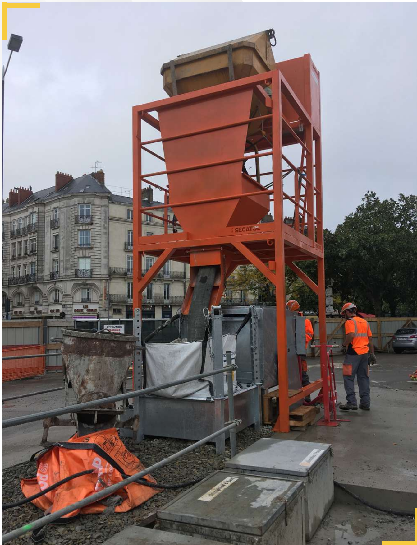
Exemple d'utilisation d'une tour de lavage de benne à béton
